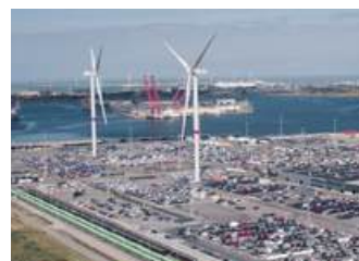
完成車ターミナル内に設置された風力発電タービン(ベルギー)
