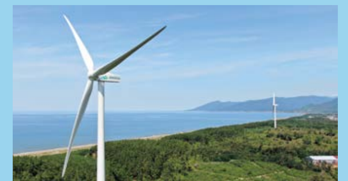
秋田県山本郡八峰町の峰浜風力発電所 (横浜港大黒C-3ターミナルの電力として100%供給中) 写真提供: ウェンティ・バル八峰合同会社
